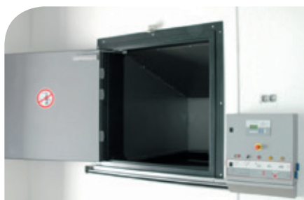
Raccordement mural avec la porte coupe-feu (de T00 - T90), commande externe avec écran et barre de sécurité
