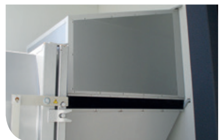
Raccordement mural avec la porte coupe-feu (de T00 - T90), commande externe avec écran et barre de sécurité
